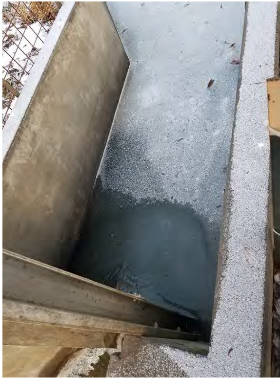
Photo A4-25 : Site walk ST037-WCSW02; Concrete weir (11/18/16)
